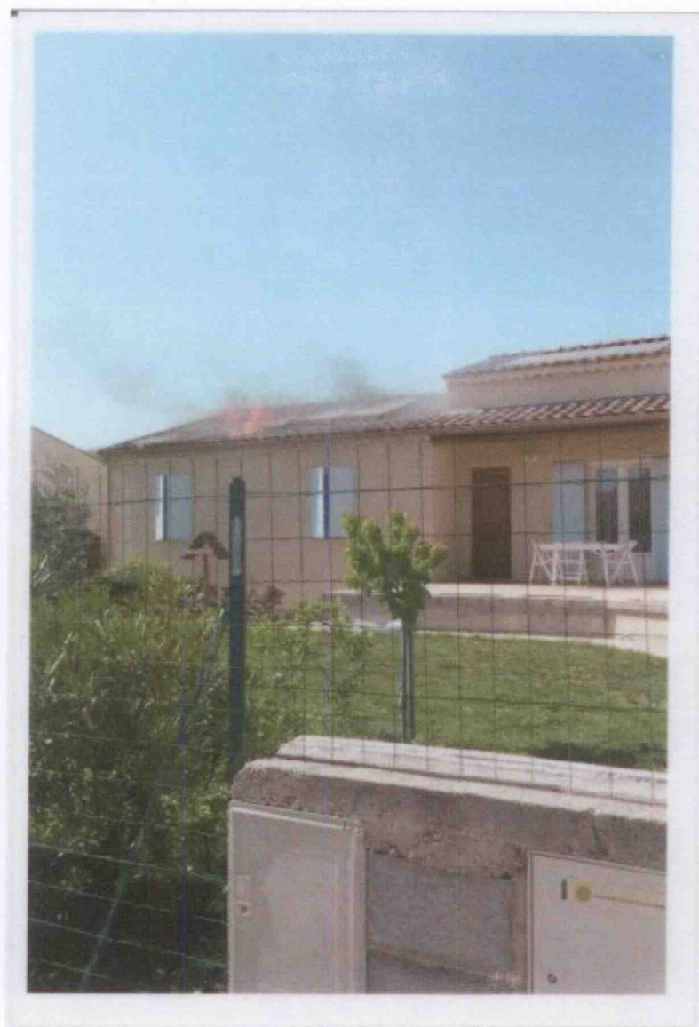
Maison en feu suite à une défaillance de panneaux photovoltaïques « Scheuten » 15 avril 2014 – VALREAS (84)
