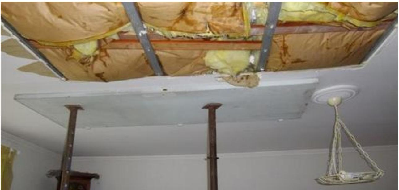
Exemple de malfaçon : une plaque d'étanchéité mal fixée, recroquevillée suite aux contraintes thermiques aggravées par l'intégration, dévoile un trou béant dans la toiture, sous les panneaux.
