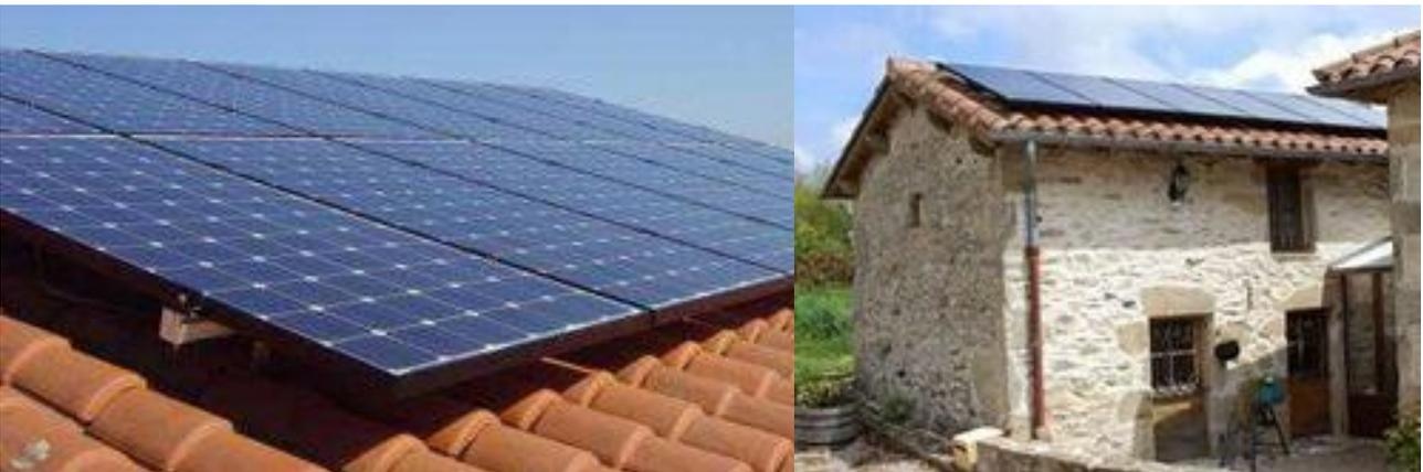
Exemples de deux modules surimposés pour seulement quelques mètres carrés de toiture.
