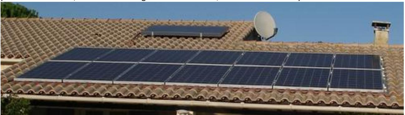
Un module solaire thermique « surimposé » avec une installation photovoltaïque « intégrée »
