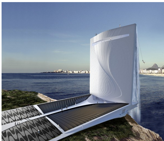
la Tower Solar City de Rio
